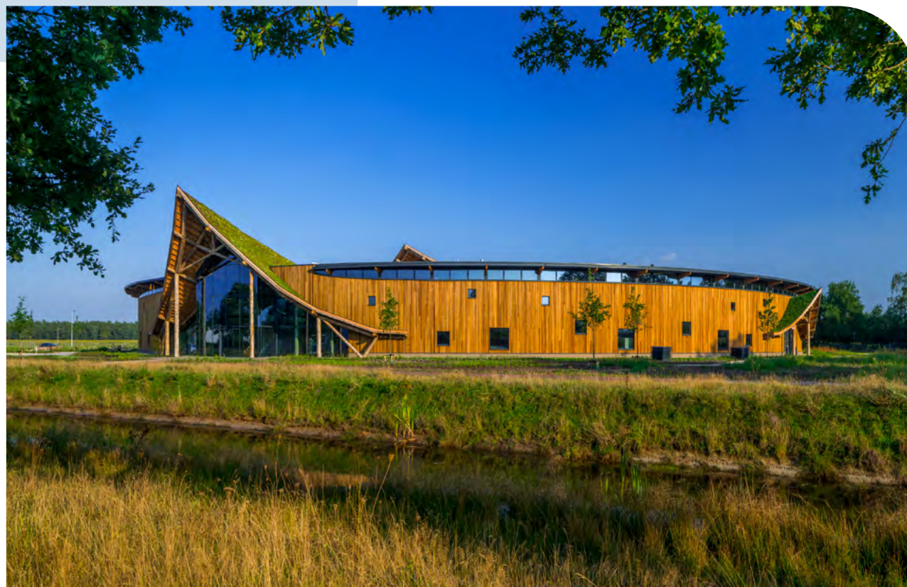
We willen onze werklocaties toekomstbestendig maken met volop aandacht voor onder andere klimaatadaptatie, energietransitie, circulaire economie en biodiversiteit. Een mooi voorbeeld hiervan is Niverplast in Nijverdal dat volgens BREEAM-certificering is gebouwd. (Foto: Foreco)
