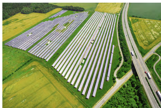
De transformatoren logisch plaatsen in het zonneveld
